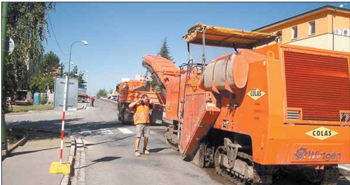
O ODSTRANĚNÍ starého asfaltu na ulici Modřínová se postarala příslušná technika.
