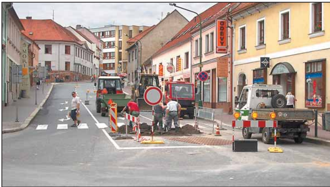
NEPŘÍJEMNÉ KOMPLIKACE způsobilo zejména motoristům několikadenní uzavření části ulice Bedřicha Václavka. Vynutila si ho oprava havarijního stavu kanalizace, kterou provedli pracovníci Vodárenské akciové společnosti. Foto: Luboš Janoušek
