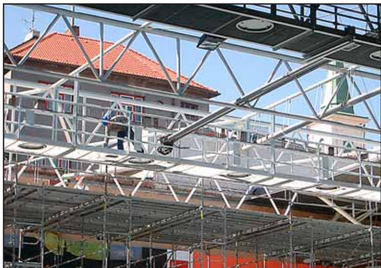
PODOBNÝ POHLED z plochy zimního stadionu je už minulostí, neboť oprava jeho střechy už byla dokončena. Foto: Luboš Janoušek
