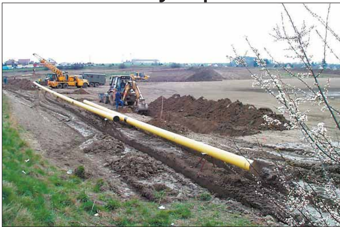
SNÍMEK pro pamětníky. Takto to v lokalitě Vídeňský rybník vypadalo na začátku roku 2007, kdy se zde rozběhly první stavební práce.
