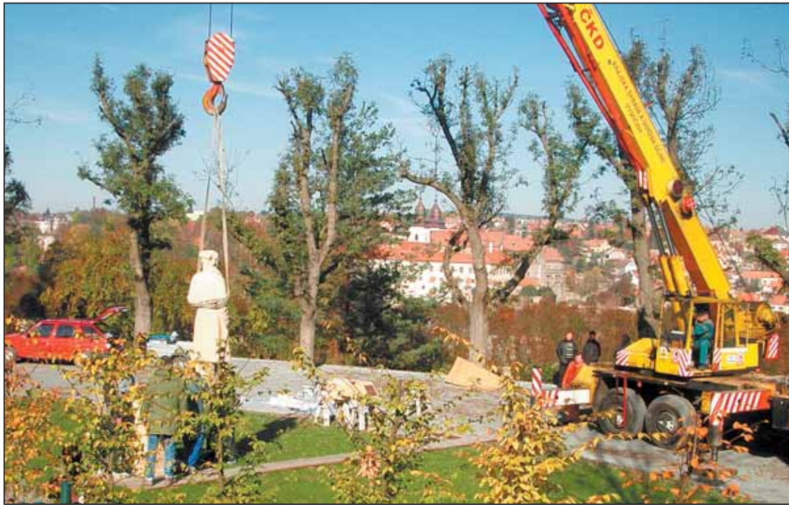
INSTALACE tunu vážící pískovcové sochy se v Tyršových sadech neobešla bez použití těžké techniky. Foto: Luboš Janoušek
