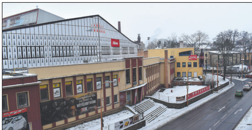
HORÁCKÝ ZIMNÍ STADION byl zastřešený v roce 1967. Ke konci dubna roku 2022 jeho životnost skončila a nelze ho dále bez rekonstrukce používat. Vlastník, město Jihlava, se rozhodlo stadion zbourat a na jeho místě postavit novou multifunkční halu.
