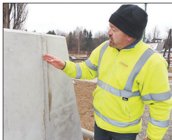
STAVBYVEDOUČÍ Karol Humeník ukazuje na spáru, za níž jsou zabetonovány konce lan. Foto: Petr Klukan
