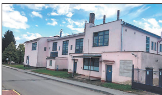
STÁVAJÍCÍ kotelná dozná zásadní rekonstrukci.
