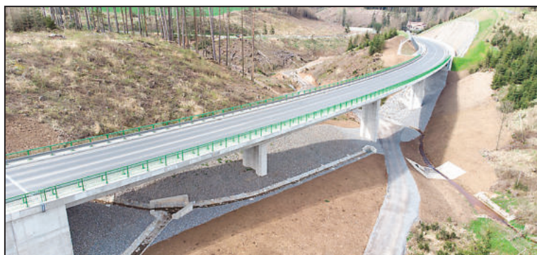
PLUSEM obchvatu Velkého Beranova je podle odborníků fakt, že si realizace jeho stavby nevyžádala demolici žádných obytných a průmyslových objektů.
