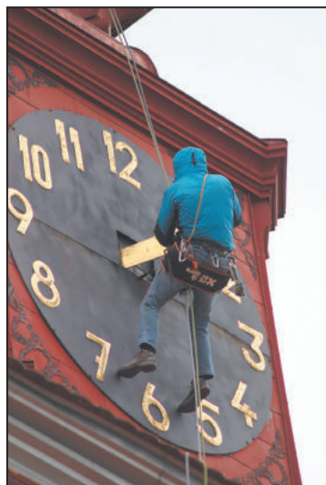
Z RADNIČNÍCH hodin byly nejdříve odstraněny rařičky, až poté ciferník, pod kterým se objevil původní.
