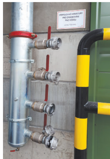
Poloautomatický hasicí systém, na který se mohou připojit hasiči. (PI-J04-14D)
