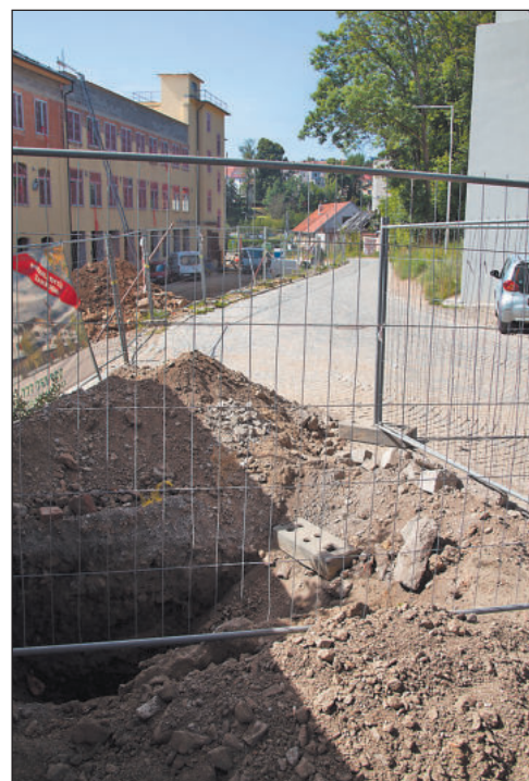
PRÁCE na rozšíření vozovky probíhají tento měsíc pod Brněnským mostem v ulici Křižíkova.
