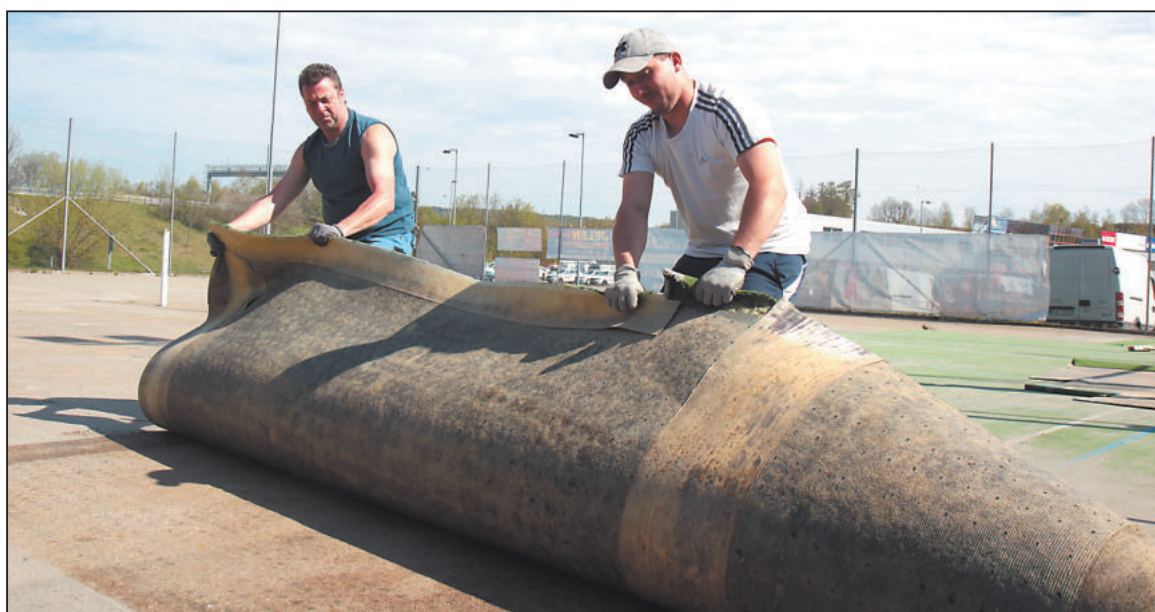
TENISTÉ SE DOČKALI. Umělá tráva na tenisových kurtěch na Vodním ráji byla v provozu od roku 2003 a byla již značně opotřebovaná. Proto Služby města Jihlavy přistoupily ke kompletní výměně za novou. Celková rekonstrukce vyjde na 0,5 milionu korun. Termín dokončení prací je stanoven na 15. května. Foto: Lubomír Maštera
