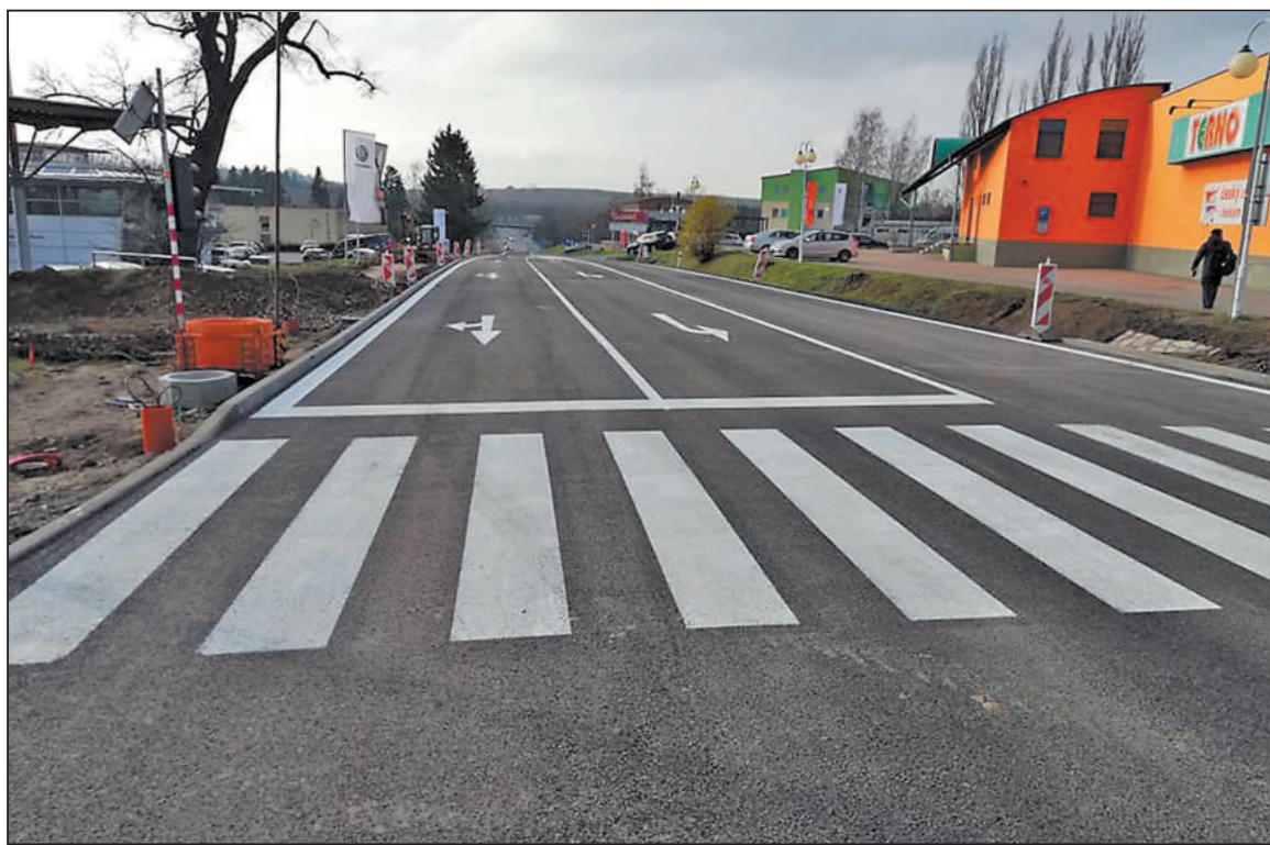
ÚPRAVA křižovatky Žižkovy a Rantířovské ulice, do které spadá i výstavba záchytného parkoviště P+R, byla dokončena se čtvrtročním předstihem. Foto: archiv MMJ
