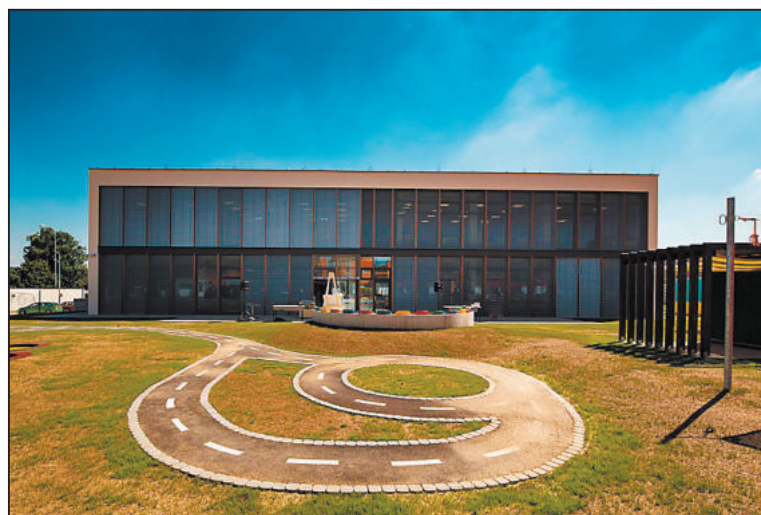
ZÁKLADEM MŠ Na Dolech je střecha, která zadržuje dešťovou vodu a solární panely, které podporují přívod elektrické energie. Foto: archiv MMJ
