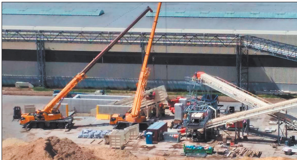
NA ZAČÁTKU června začaly v areálu společnosti stavební práce bez potřebných povolení. Podle mluvčí společnosti šlo o montáž části technologického zařízení, práce se však po upozornění jihlavské radnice pozastavily. Foto: archiv MMJ
