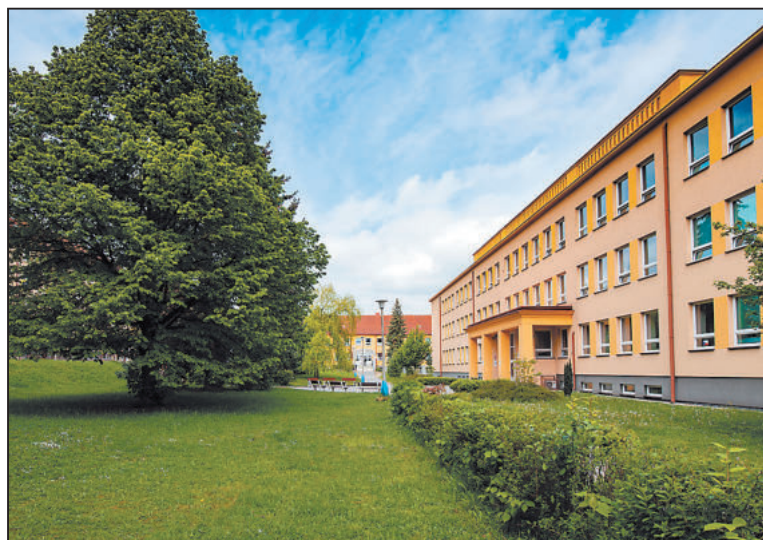
POTENCIÁL. Pohled na školu Evžena Rošického – zelené plochy bez využití, ale i obrovský potenciál pro práci architekta, pro hru i výuku, pro trávení volného času i mimo školu.
