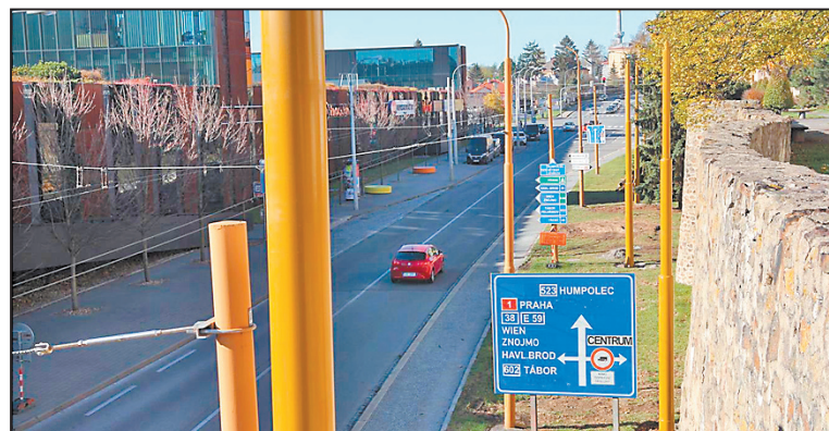
U CITY PARKU byly přesunuty trakční stožáry a příští rok se bude realizovat rozšíření ulice Hradební.
