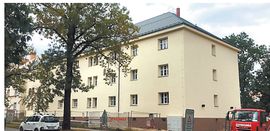
Foto z doby probíhající rekonstrukce.
