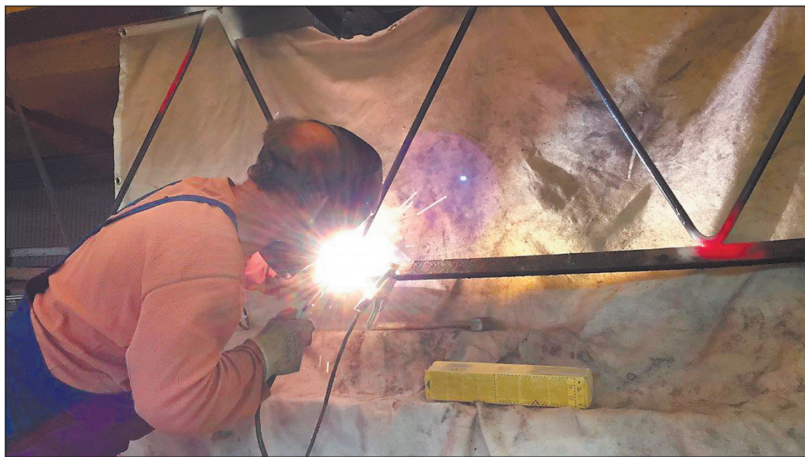
SKORO 180 tisíc korun stála oprava nosníků střechy Horáckého zimního stadionu.
