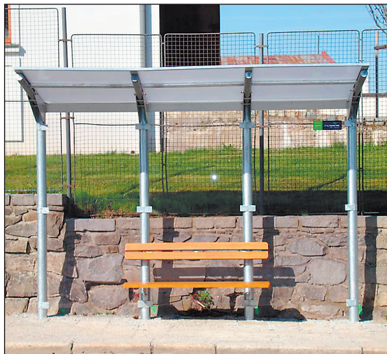
NOVÉ přístřešky na zastávkách MHD se objevily v ulicích Brtnická, Znojemská a Zimní.
