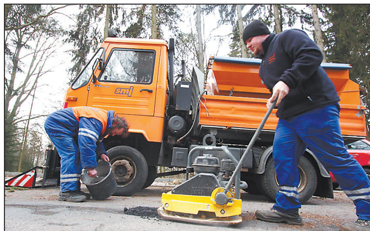
DLOUHÁ zima se zákonitě podepsala na stavu jihlavských vozovek. Na způsob opravy jsme se ptali náměstkyně primátora Jany Mayerové na str. 6 tohoto vydání. Pracovníci Služeb města Jihlavy používají směs Canader-mix pro nejnaléhavější případy.
