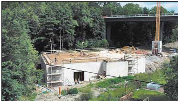
FOTOGRAFIE odkrývá pravou podobu podzemní nádrže před zakrytím zemí. Foto: archiv MMJ
