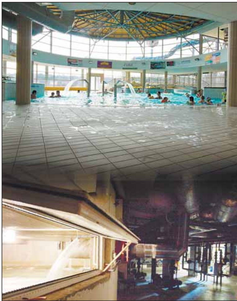
VODNÍ ráj v Jihlavě, jeho krytá část, to není jen prostor pro návštěvníky a rekreanty. Pod zemí se skrývá technická část areálu, která vyžaduje trvalou obsluhu.
