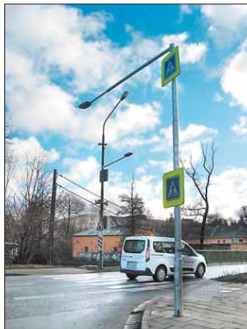
NOVÝM nasvětleným přechodem je přechod na křižovatce Havlíčkova – Polenská.
