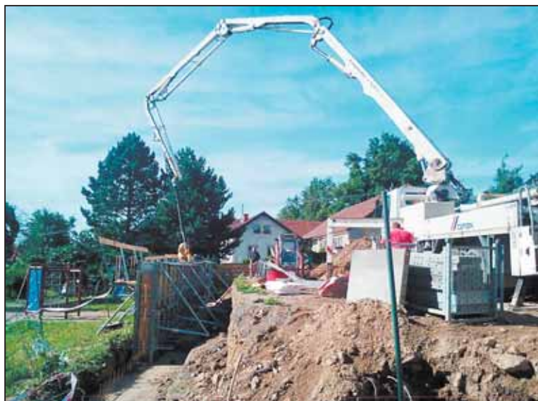
V POPICÍCH se staví víceúčelové hřiště, sportovci se těší na možnosti nového využití. Foto: archiv MMJ
