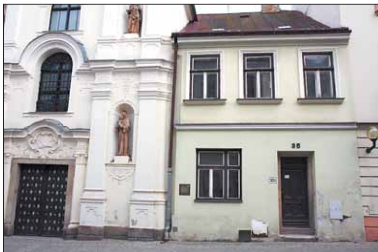
KULTURNÍ PAMÁTKA. Dům v ulici Matky Boží čp. 1034 se stal nemovitou kulturní památkou Kraje Vysočina. Nejstarší stavební částí domu jsou cenné pozůstatky gotické kaple, která přiléhala k západní boční lodi kostela.
