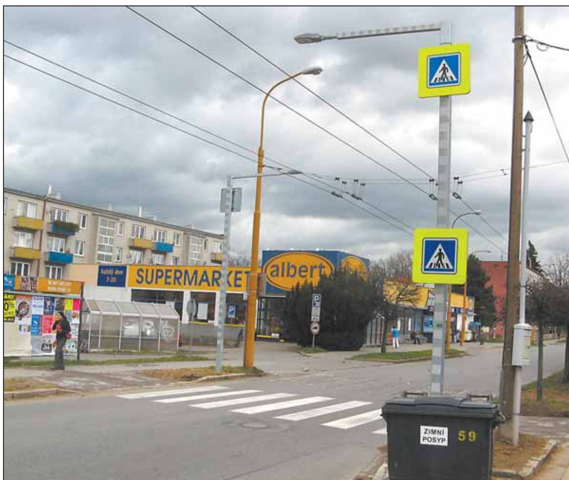
JIHLAVA postupně navyšuje bezpečnost chodců budováním nasvětlených přechodů, které snižují možnost srážky s vozidlem. Foto: archiv MMJ
