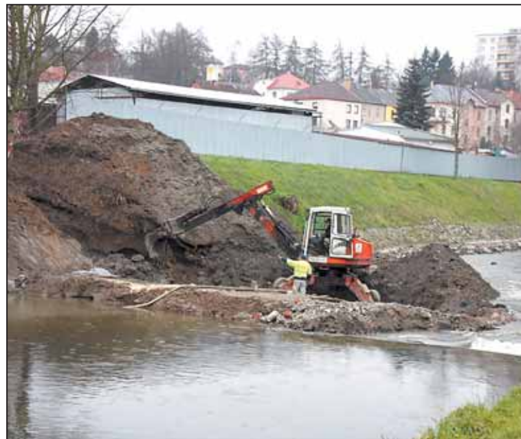
V RÁMCI projektu na snížení znečištění ve vodních tocích se v prosinci pracovalo také v korytu řeky v ulici Mlýnská.
