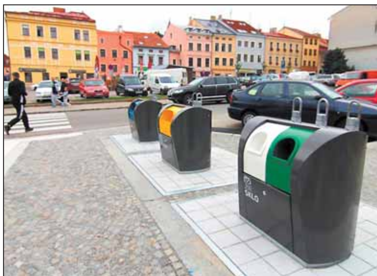
PODZEMNÍ KONTEJNERY. Jihlava v září oficiálně uvedla do provozu dvě stanoviště podzemních kontejnerů na tříděný odpad. Z ulic tak zmizely rozměrné plastové nádoby, které nahradily méně výrazné „komíny“ pro vhazování odpadu do podzemí. V případě nového stanoviště u křižovatky pěti silnic (ulice Palackého, Bezručova a Jana Masaryka) nové řešení rovněž přispělo k bezpečnosti provozu zejména chodců.
