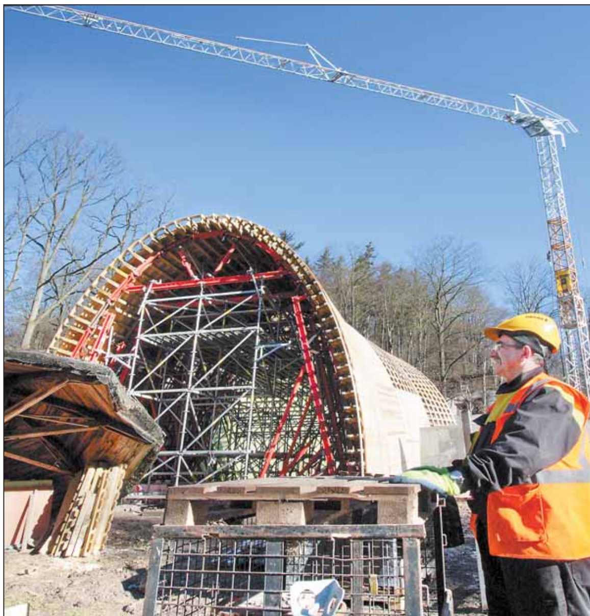
JIHLAVSKÉ zoo již delší dobu dominuje výškový jeřáb a pod ním probíhající stavební činnost. Projekt Zoo pěti pavilonů vstupuje do své finální fáze, a tak se nedá ani mluvit o zimním klidu, nehledě na nezvyklé jarní počasí. Foto: Lubomír Maštera
