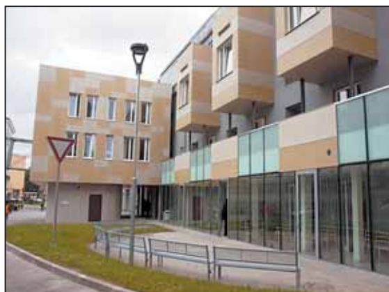
VYBUDOVÁNÍ a zkušební provoz Domova seniorů Stříbrné Terasy v Jihlavě v Havlíčkově ulici je definitivně u konce, projekt byl dokončen stavebně i administrativně.
