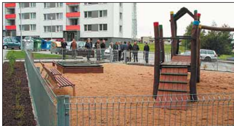
SKORO o dva měsíce dříve skončily rozsáhlé úpravy jihlavského sídliště Královský vršek. Nákladem 17,3 milionu korun zde vznikly dvě stovky parkovacích míst, nová dětská hřiště, chodníky, fitkoutek s venkovními posilovacími stroji či klidové plochy s výhledem na město.
