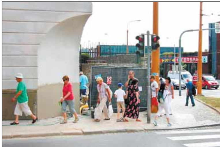
ÚPRAVOU rohu budovy na Znojenské ulici se rozšířil prostor pro chodce a značně tak vzrostla bezpečnost křižovatky. Foto: archiv MMJ
