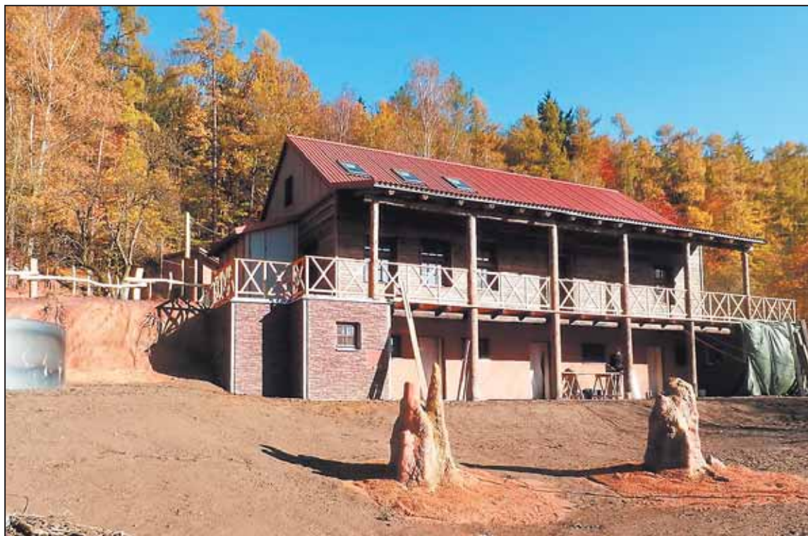
JIHLAVSKÁ zoo se začíná plnit. V rámci projektu Zoo pěti kontinentů rostou nové stavby a první z nich, australský pavilon, bude otevřena 20. dubna. Foto: archiv MMJ
