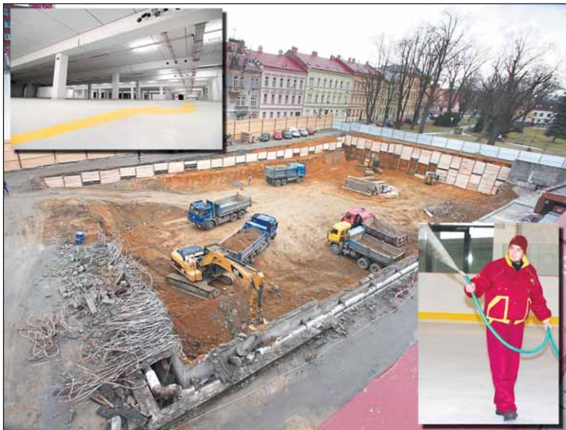
ZIMÁČEK ve stavu zrodu a zimáček těsně před dokončením. Jihlavská veřejnost se dočkala, na chlazeném betonu vzniklo několik centimetrů nového ledu a veřejnost ho může vyzkoušet. Foto: Lubomír Maštera, archiv MMJ
