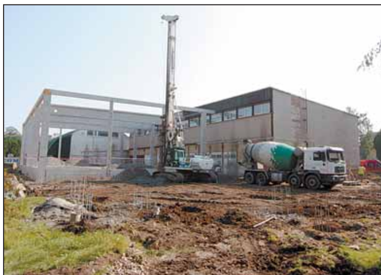
V TENISCENTRU se prohání stavební stroje. Probíhá rekonstrukce areálu.
