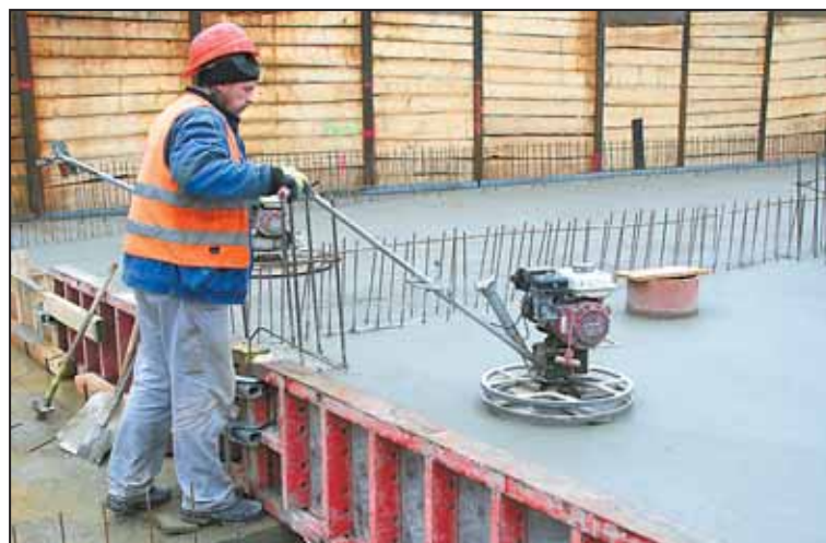
NA STAVBĚ VEDLEJŠÍ haly zimního stadionu se začala pokládat základová deska.
