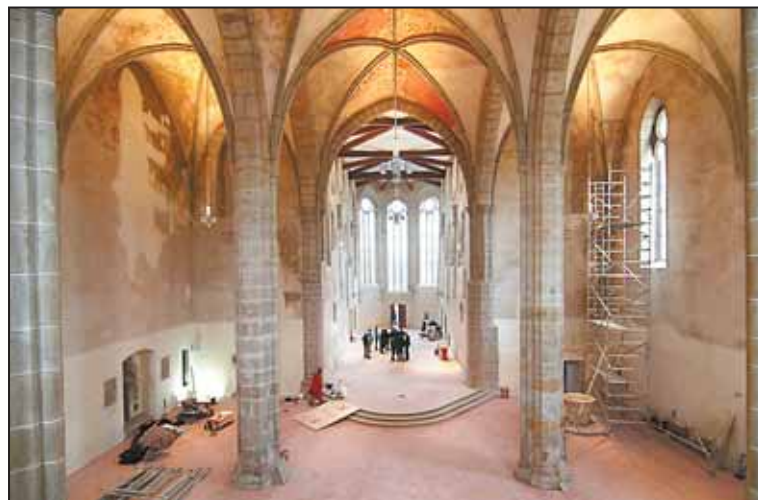
KONCEM ledna skončila první etapa rekonstrukce kostela Povýšení sv. Kříže.
