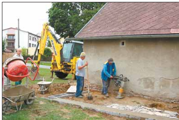
ZÁZEMÍ PRO HEROLTICKÉ. V části města Jihlava - Heroltice se upravuje tzv. objekt občanské vybavenosti. Budova využívaná osadním výborem, dobrovolnými hasiči a například také jako volební místnost už vyžadovala opravu a rozšíření. Buduje se přístavba s novým vstupem do objektu, sociální zařízení a sklad, upraví se vnitřní dispozice, doplní sítě a osvětlení, budova se částečně zateplí. „Objekt už rekonstrukci potřeboval. Přesněji řečeno si lepší zázemí pro svoje činnosti zaslouhuje Heroltice,“ řekl k investici primátor Jaroslav Vymazal a připomněl, že v Herolticích působí jedna ze čtyř jihlavských jednotek dobrovolných hasičů. Rekonstrukce přijde na necelý jeden milion korun, hotová bude koncem září. (Stránku připravil -lm-)
