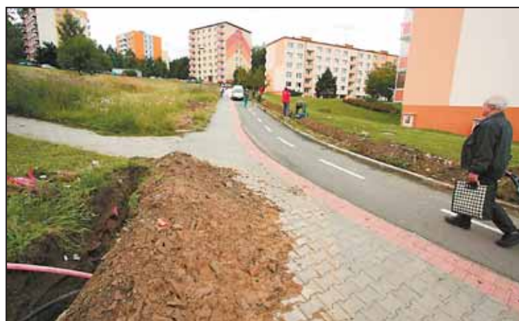
ROZKOPANÉ BŘEZINKY. Na sídlišti Březinova se již zase kope. Důvodem je tentokrát pokládka kabelů kolem části nové cyklostezky.
