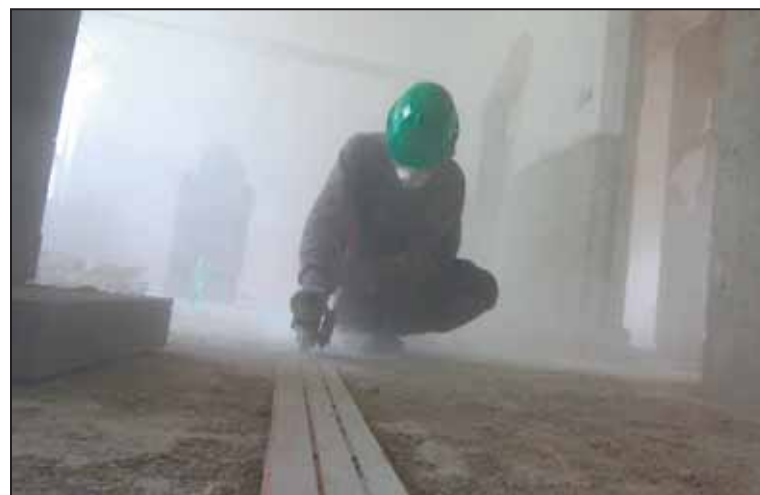
REKONSTRUKCE MŠ. V plném proudu je práce v mateřské škole v Jihlavě - Antonínově Dole. Do října přibudou dvě nové třídy po pětadvaceti dětech, celková kapacita mateřinky tedy bude sto dětí. Budova zároveň prochází rekonstrukcí, vymění se okna, zateplí stěny atd., náklady jsou cca 7,8 milionů korun. Dalších 50 míst přibude na jaře v rekonstruované školce v Jarní ulici, a od října 2012 bude 50 nových míst v Resslově ulici. Unikátní mateřinka pro dvacet dětí vzniká také v Jihlavě - Zbozně. Jmenuje se Dětský lesní klub Hájenka, odlišná bude zaměřením na přírodu a pokud možno co nejčastějším pobytem dětí venku. Dalších asi 50 míst vznikne v prostorách domova mládeže Na Stoupách, po rekonstrukci bude vyšší kapacita o 25 míst v mateřské školce Kollárova. Od září 2012 bude 100 míst v ZŠ Nad Plovárnou.
