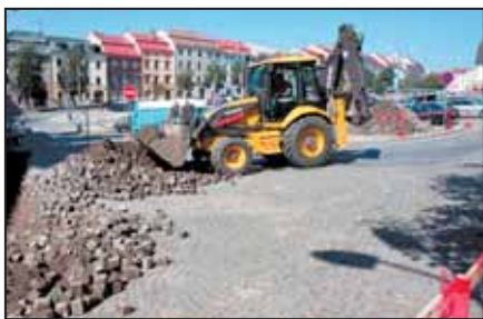
PO MASARYKOVĚ náměstí se prohánějí bagry. Děje se tak v rámci bezbariérových úprav náměstí.
