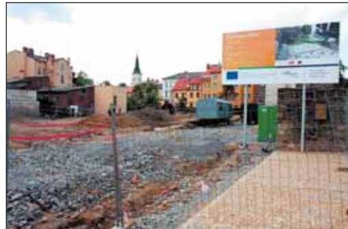
PROSTOR bývalé tržnice je nyní prostorem stavebních úprav pro Park Gustava Mahlera.
