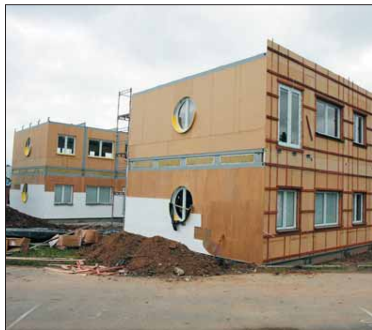
MŠ DEMLOVA 34a HOTOVÁ. Těsně před dokončením je nová Mateřská škola Demlova 34a. Kapacita školy má být 100 dětí, součástí školy bude přípravná jídel, technické a sociální zázemí, zahrada a dětské hřiště.
