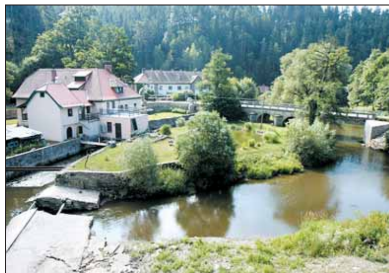
MOST HULOVA JE PŘED REKONSTRUKCÍ. Přes řeku Jihlavu o odbočky do Malého Beranova stojí most v majetku města, který potřebuje celkovou rekonstrukci. Zatím město na tuto opravu nevyčlenilo peníze, ale o stavu mostu má přehled. Oprava si vyžádá investice v rozsahu asi 20 milionů korun.
