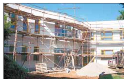
VNĚJŠÍ ÚPRAVY na nově vybudované přístavbě školy.
