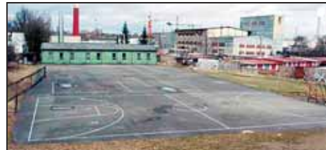
STAV SPORTOVNÍHO areálu při základní škole Kollárova před rekonstrukcí.
