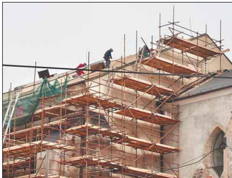
INTENZIVNĚ SE pracuje také na opravě střechy kostela Povýšení svatého Kříže.
