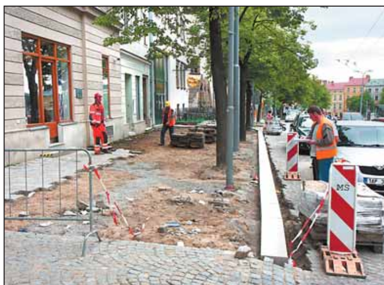
REKONSTRUKCE ZASTÁVEK MHD. Na řadě míst krajského města můžete vidět rozkopaná území, připravená pro nové bezbariérové zastávky MHD. Úpravy se týkají nejen centra města, ale celé Jihlavy.
