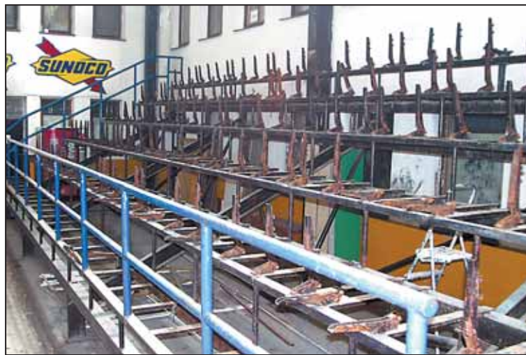
TRIBUNA za brankou je zbavena sedáků a postupně se likviduje kovová konstrukce. Foto: Vladimír Štátný
