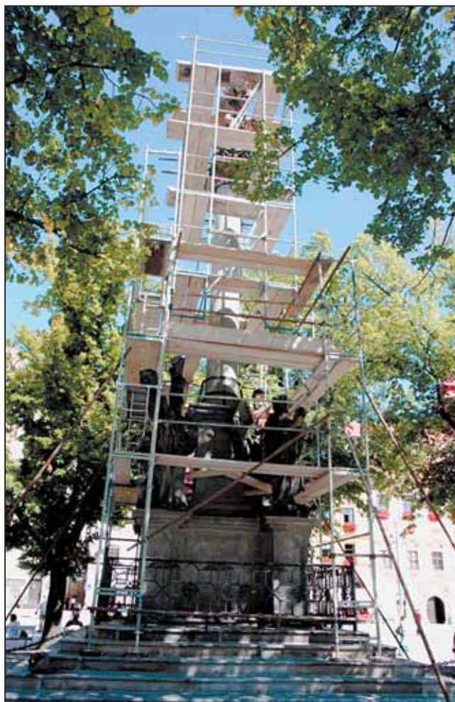
MOROVÝ SLOUP prochází rekonstrukcí.
