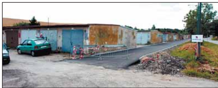
MAJITELÉ garáží na Telečské ulici požadují v petici nadstandardní přístup města k příjezdovým komunikacím. Foto: Lubomír Maštera
