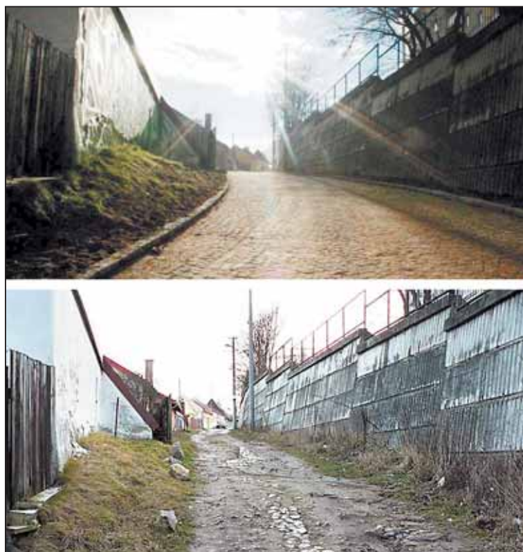
POHLED na ulici Úlehlova před a po rekonstrukci.
