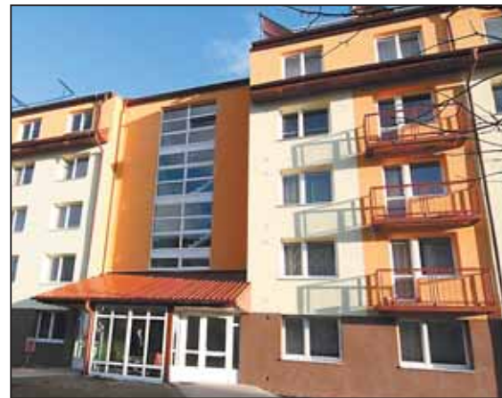
REKONSTRUKCE DPS Za Prachárnou 4501/1a stála 8 milionů a na domu je to poznat. Foto: archiv NJR
