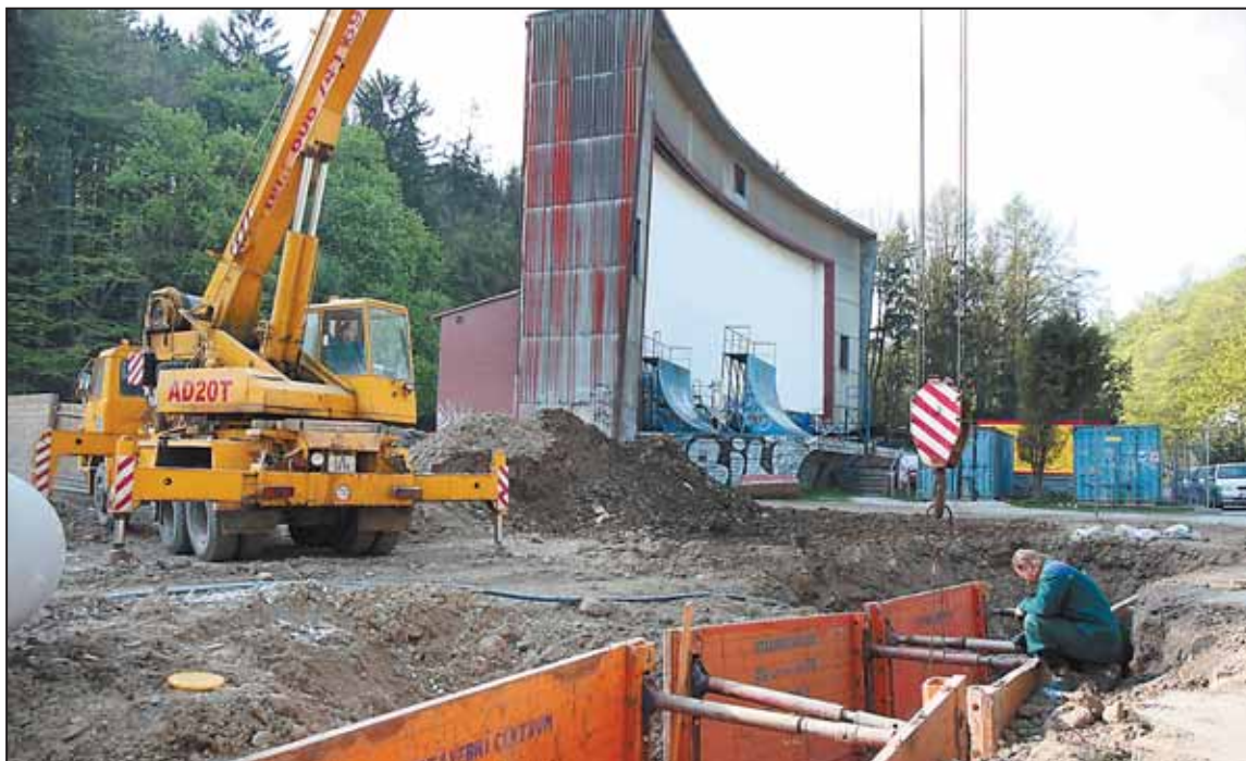
REKONSTRUKCE areálu Malý Heulos pokračuje zemními pracemi vedle a za promítací stěnou. Foto: Lubomír Maštera
