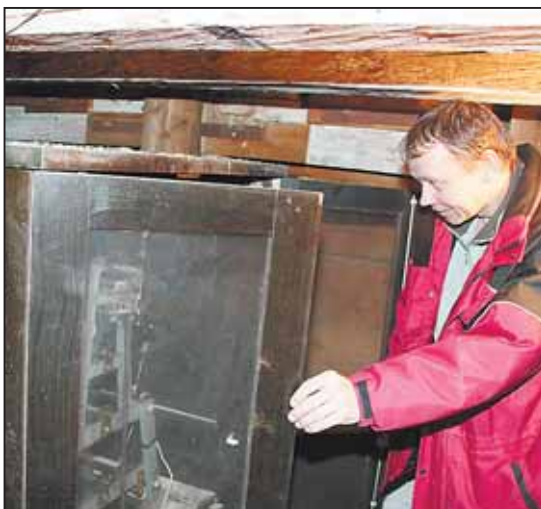
PAVEL SAHULA z oddělení správy budov je pověřen pravidelnou kontrolou a údržbou radničních hodin.
