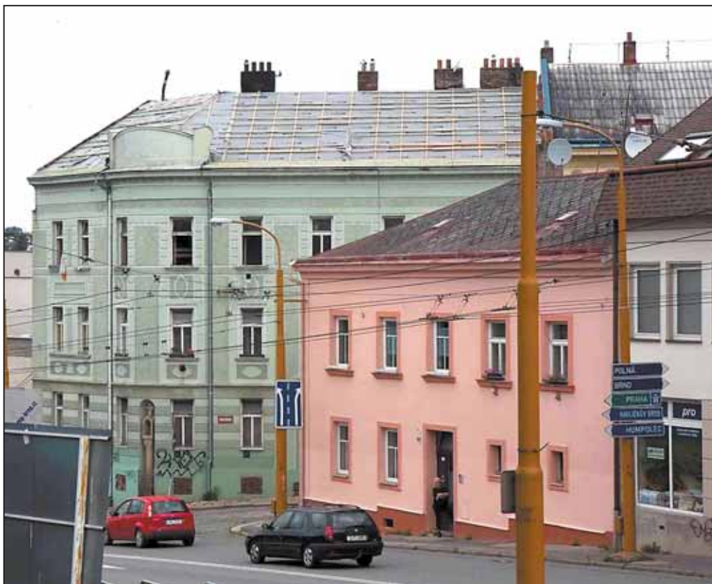
VYHOŘELÝ dům v Třebízského ulici již má novou střechu, která je v tomto deštivém počasí nutností proti promáčení domu.
