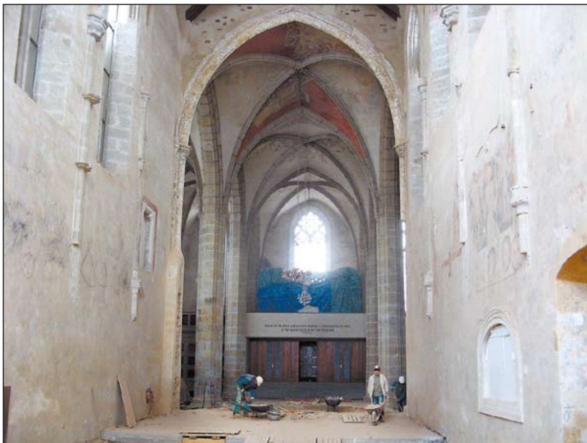
KOSTEL Povýšení sv. Kříže prochází rozsáhlou rekonstrukcí. Pracovníci odstranili čelní stěnu, která uměle rozdělila kostel na dvě části, opravovat se bude střecha, venkovní omítky, dojde k odvlhčení zdí a vznikne zázemí pro pořádání kulturních akcí. Foto: archiv NJR
