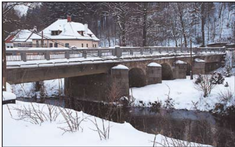
MOST u Malého Beranova posloužil při opravách jako objíždka, ale nyní překáží velké vodě. Foto: Vlasta Böhmová
